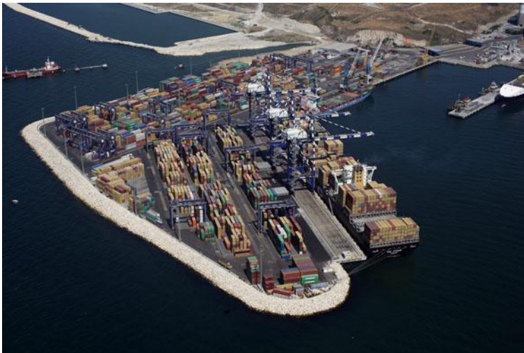
BU: Marport Terminal Operators S.A rüstet seine RTGs im Marport West Terminal auf Elektobetrieb um
